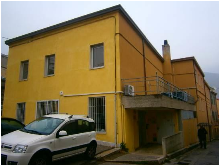
edificio via Zanella
